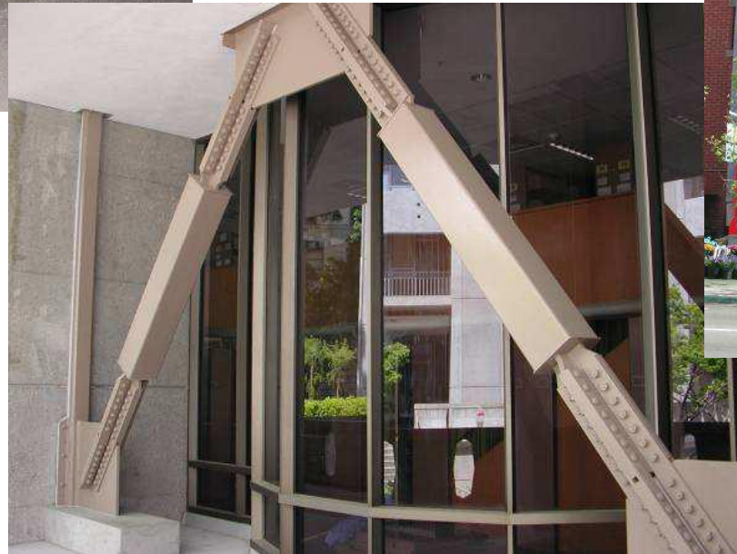
Eléments de stabilité avec amortisseurs
