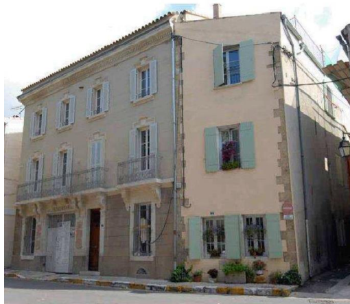
Bâtiment en maçonnerie
