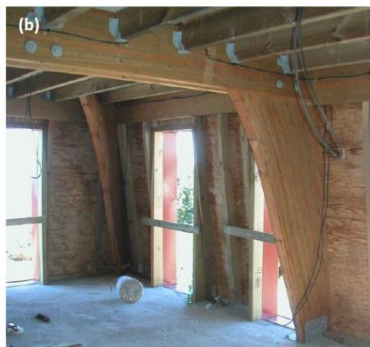
Charpente mansardée en lamellé-collé positionnée au-dessus des deux niveaux maçonnés : (a) vue extérieure arrière gauche et (b) vue intérieure
