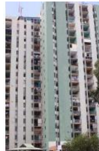
Bâtiment en béton
