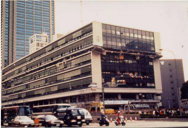
Kobé 1999 Mairie, rupture du 6 ème niveau
