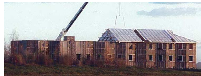
Bâtiment en bois
