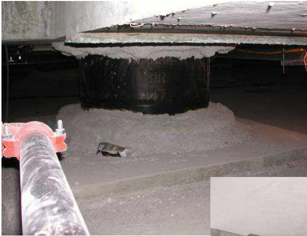
Isolateur parasismique
