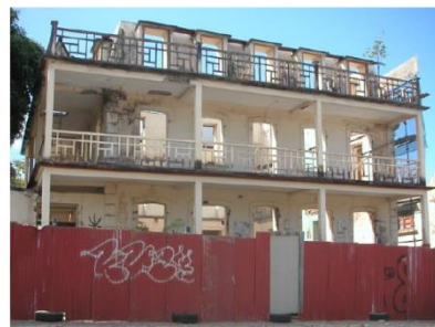
Structure existante de l'école dépourvue de sa toiture et de ses planchers bois – courives du 20 ème siècle non encore démolies – Photo de la face avant
